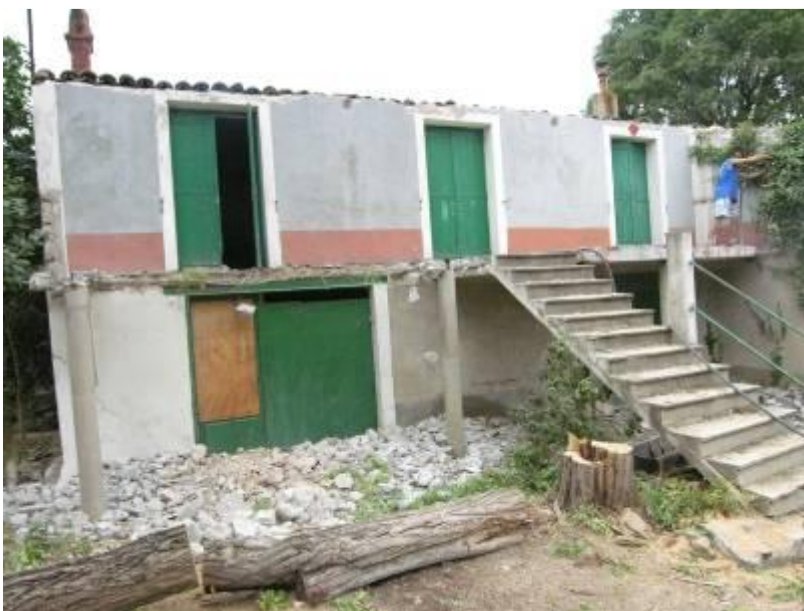
Démolition du balcon sur façade sud de l'atelier Septembre 2010
